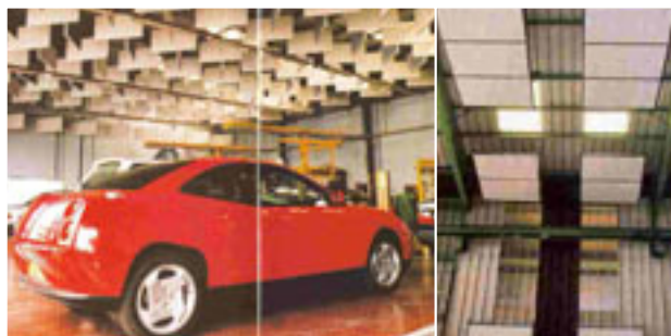
Σχήμα 4.19 Συνεργείο αυτοκινήτων – Ηχοαπορρόφηση εσωτερικού χώρου © Yves Cousson – Χορηγία του INRS – Γαλλία
